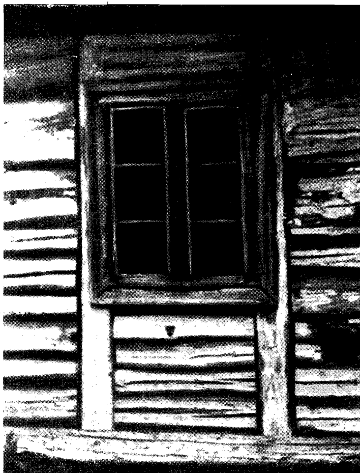
Il. 8. Węgiel „na rybi ogon” z wystającymi ostatkami. Rudniki, pow. Staszów. Il. 9. Konstrukcja okna ujętego w słupy. Jastrzębia, pow. Radom
