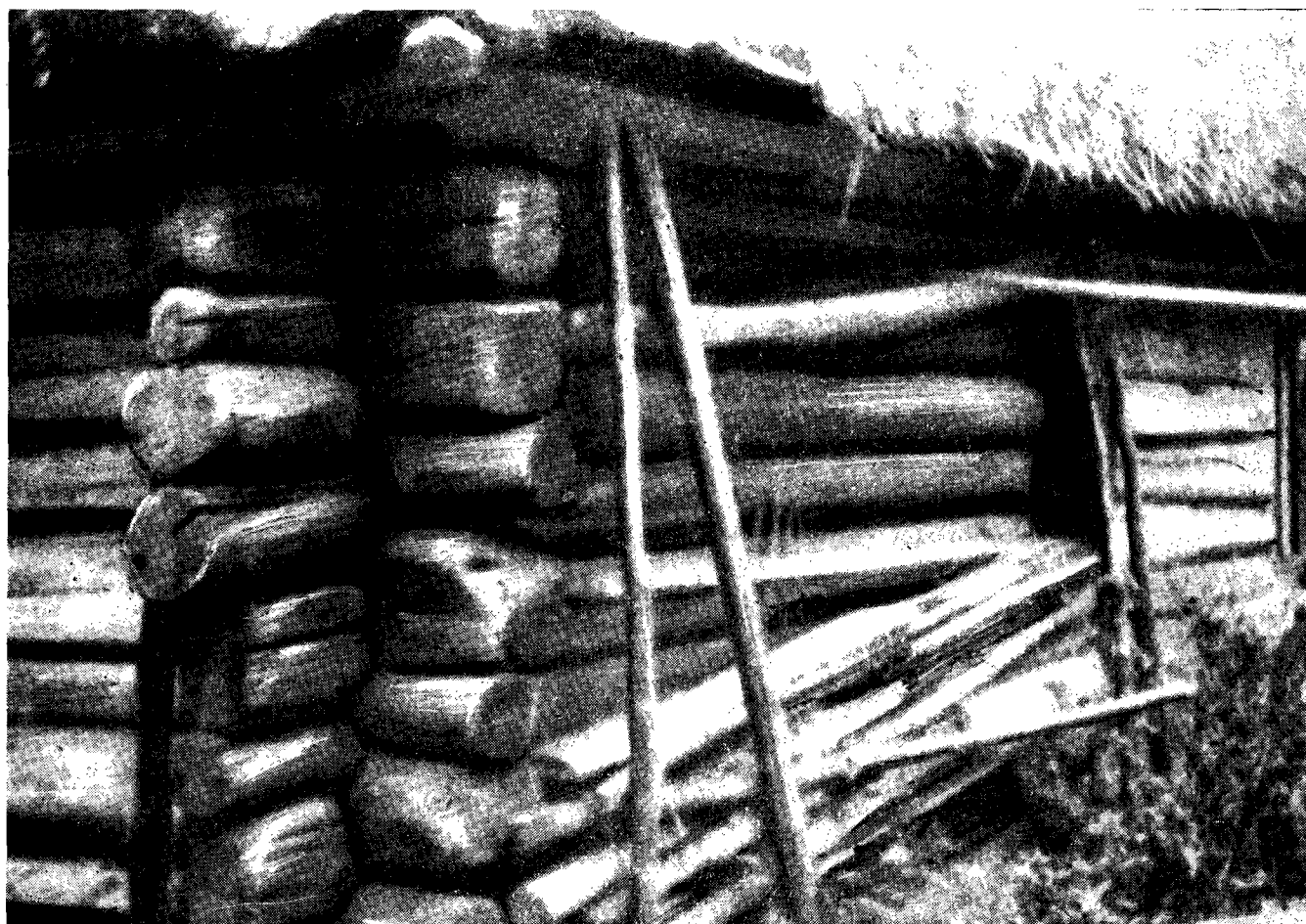
Il. 6. Chałupa o ścianach bitych z gliny. Mikułowice, pow. Busko. Il. 7. Węgły „na obłap” w chałupie sprzed ponad 100 lat. Wzdół Rządowy, pow. Kielce
