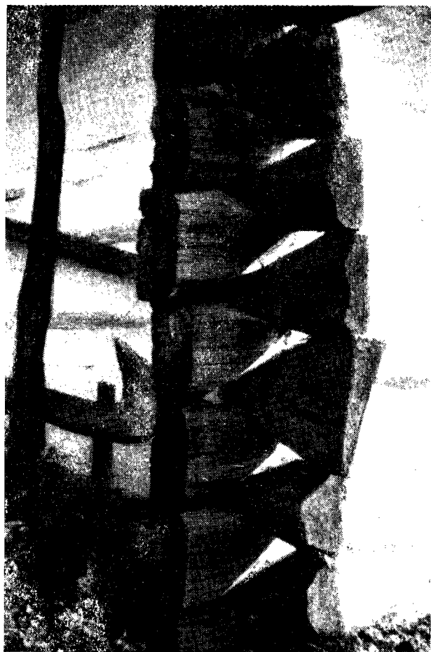
Il. 8. Węgiel „na rybi ogon” z wystającymi ostatkami. Rudniki, pow. Staszów. Il. 9. Konstrukcja okna ujętego w słupy. Jastrzębia, pow. Radom
