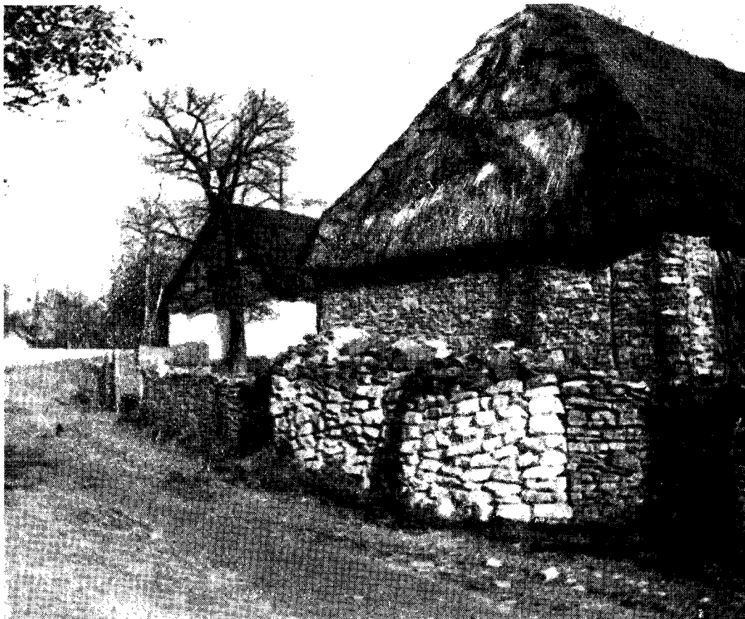
Il. 5. Budownictwo kamienne. Szaniec, pow. Busko.
