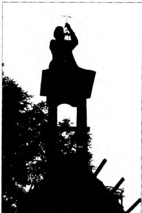
Fot. 7 Remont dachu — ponowne osadzanie krzyżyka. Fot. J. Nowak.
