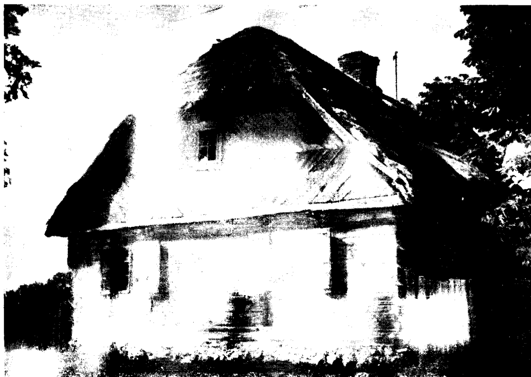
Ryc. 7. Ozdobnie szalowany dach naczółkowy. Dzierżądź, pow. Płońsk.
