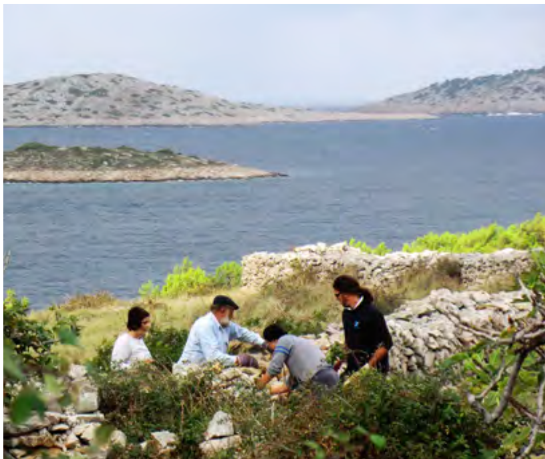
Kornati: wznoszenie i odnawianie murów z kamienia bez użycia zaprawy, 2015. Fot. Vilma Stopfer, © Association 4 grada Dragodid.
