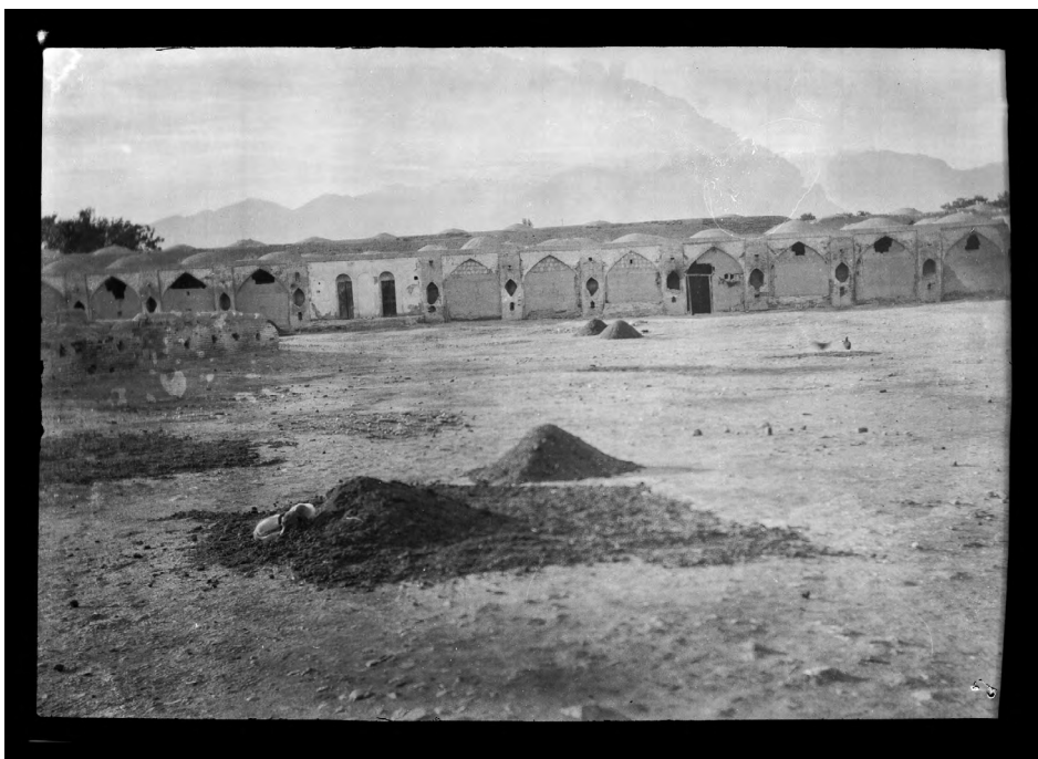
Fot. 32. Zrujnowany karawanseraj; romboidalne dziury w ścianie to żłoby dla koni; Iran. Fot. NN, 1914.
