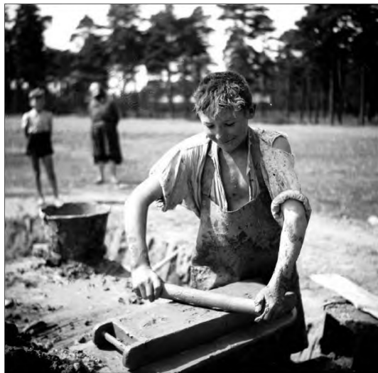
Fot. 1. Wykorzystanie strychulca w trakcie wypełniania gliną formy do cegieł. Zalesie, Bory Tucholskie. Fot. Roderyk Lange 1960 (Muzeum Etnograficzne w Toruniu).
