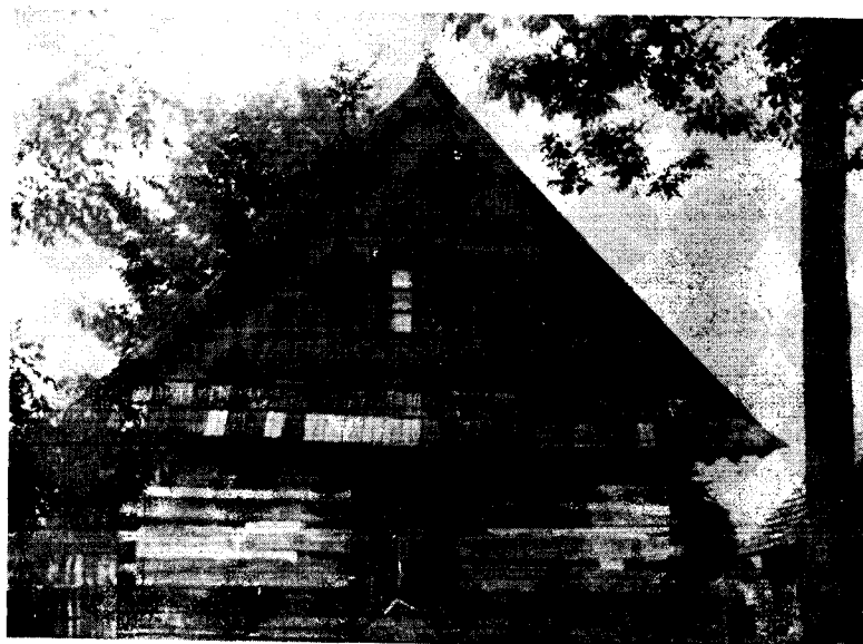
Ryc. 5. Zdobiony szczyt domu. Kamień, pow. Nisko. Fot. R. Reinfuss.
