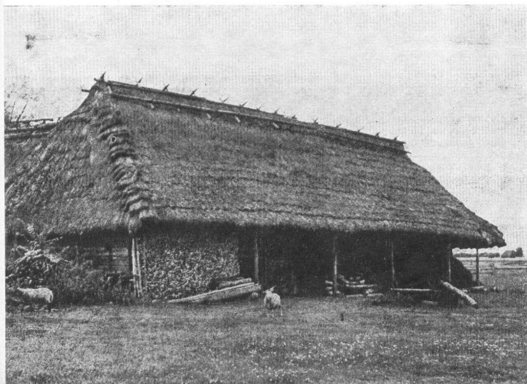
Il. 3. Stodoła o 2 „tokach” i 3 „storonach”. Nowoberezowo, pow. Hajnówka.
