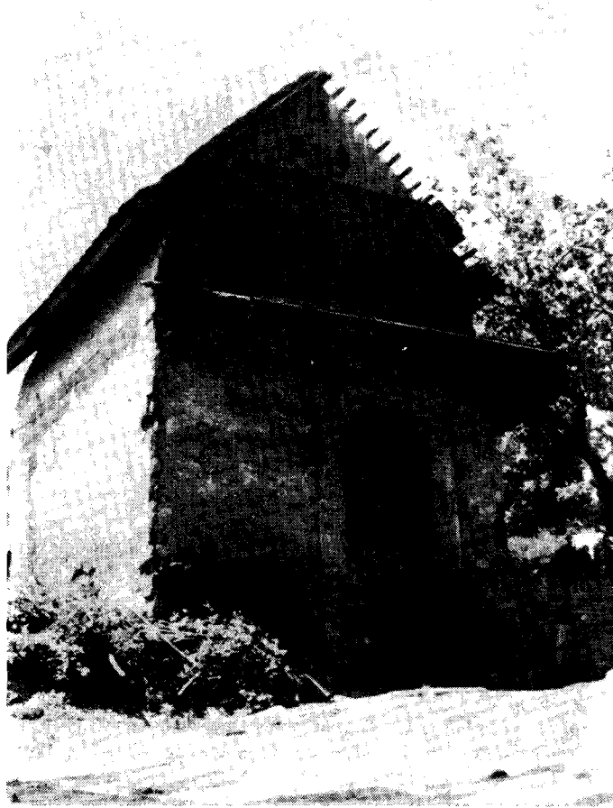
Ryc. 6. Spichlerz o kopulastym sklepieniu zrębu z zewnętrznym wejściem do piwnicy. Ligota Książęca, pow. Racibórz
