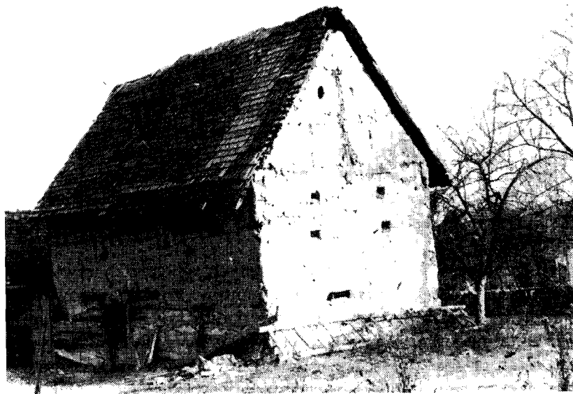
Ryc. 7. Spichlerz z XIX w., konstrukcji zrębowej z belek połączonych w narożach na tzw. zamek. Mieszkowice, pow. Prudnik
