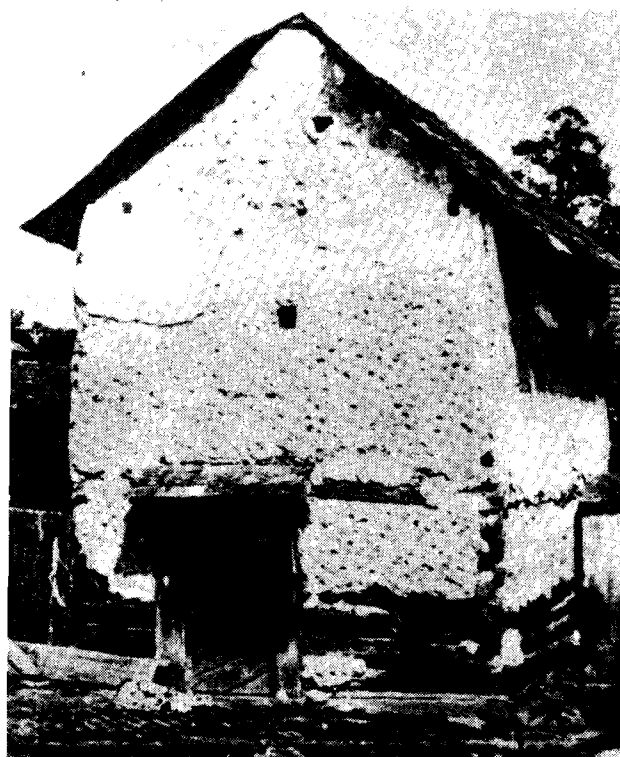
Ryc. 5. Spichlerz o ścianach zwężających się w górnej części, czym upodabnia się do spichrzy typu kopulastego. Borucin, pow. Racibórz
