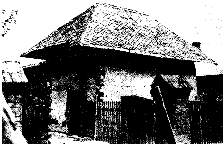
Rys. 8. Spichlerz o kopulastym sklepieniu zrębu, nakryty daszkiem czterosпадowym. Wojnowice, pow. Racibórz
