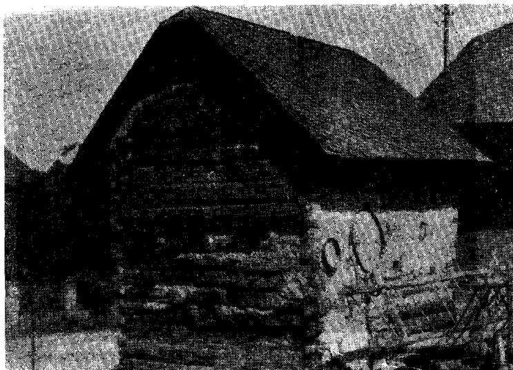
Ryc. 4. Spichlerz o kopulasto sklepionym zrębie i dachu luźno nałożonym. Borucin, pow. Racibórz
