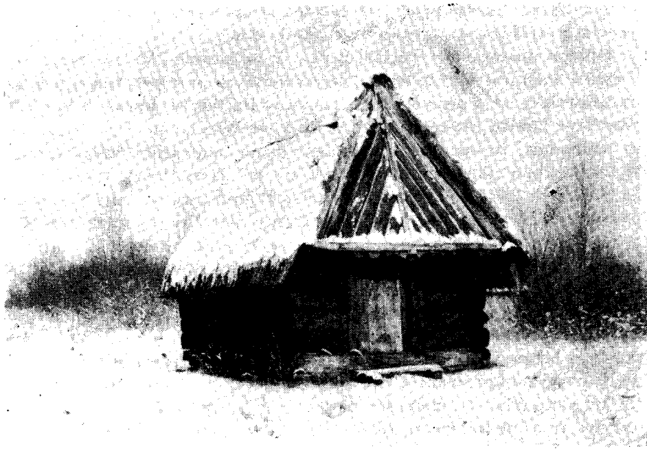
Ryc. 2. Spichlerz z dachem przesuniętym nad jedną ze ścian szczytowych. Sternalice, pow. Olesno. Obecnie obiekt usytuowany na terenie Muzeum Wsi Opolskiej w Opolu-Bierkowicach
