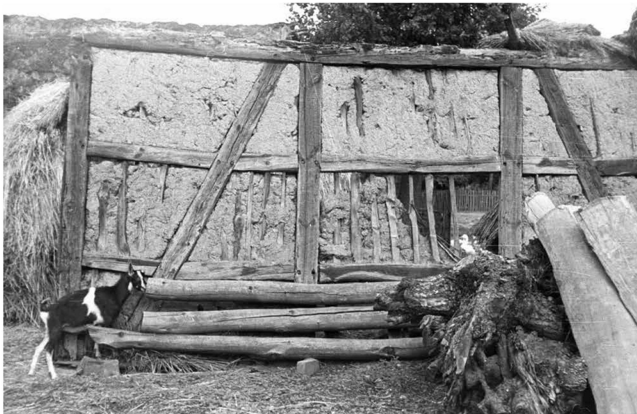
Autor: Józef Burszta Rok i miejsce: 1957, Krzykosy, pow. średzki Tytuł: Ściana stodoły - konstrukcja szkieletowa Patronat zdjęcia: Agnieszka Wrzosek
